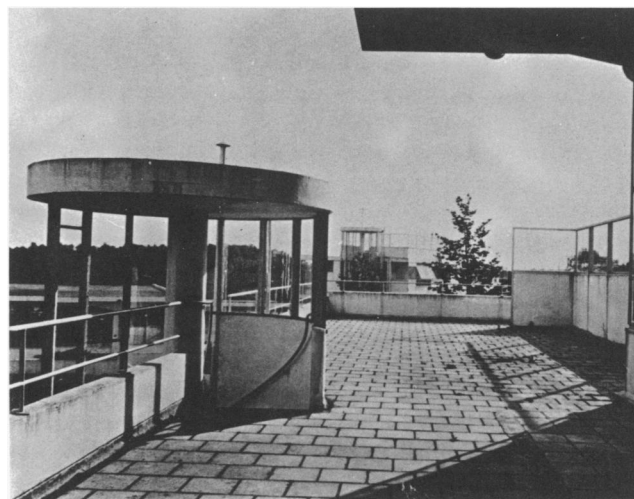
left Zonnestraal, terrace of central dining room
